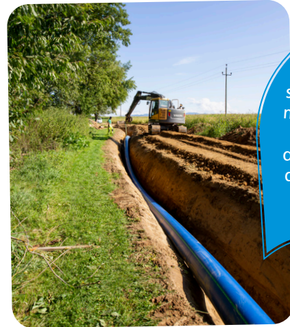
Abb. Kunststoffrohr beim Verlegen
